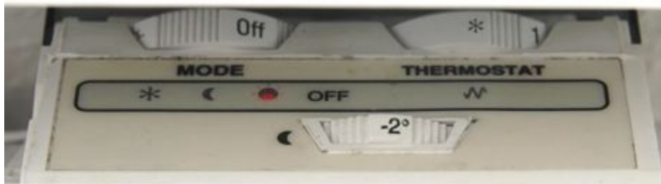
Heizung im Zimmer
